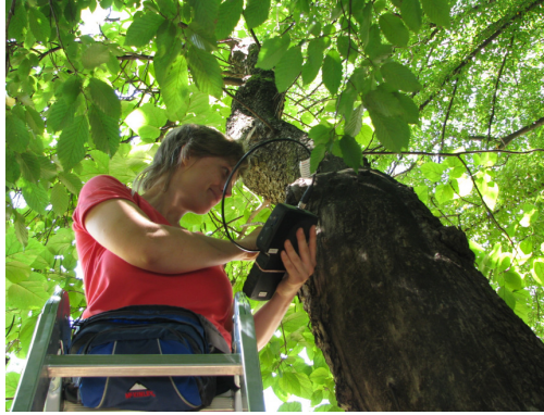
Slika 10: Pregled odprtin z optično napravo imenovano boreskop (Foto: Monika Podgorelec).
