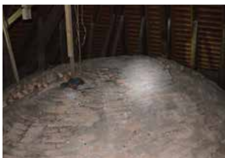
Pred čistilno akcijo na podstrešju cerkve v Češnjevku (zgoraj) in po njej.
