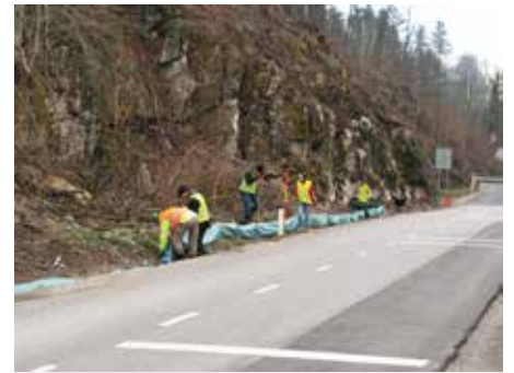
Postavljanje varovalne ograje za dvoživke.
